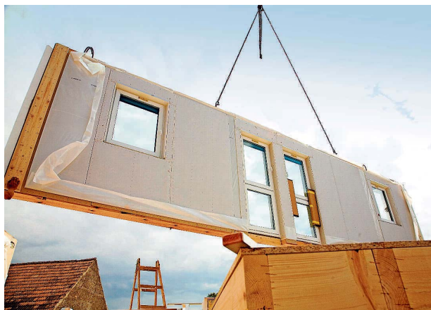
Beim Fertighaus werden die in einem Werk vorgefertigten Teil vor Ort montiert.
